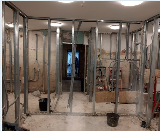
Die Feuchte zog in alle Wände. Aber auch dieses Ständerwerk fiel den Abrissarbeiten zum Opfer.
